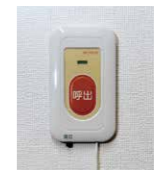
浴室緊急通報装置
